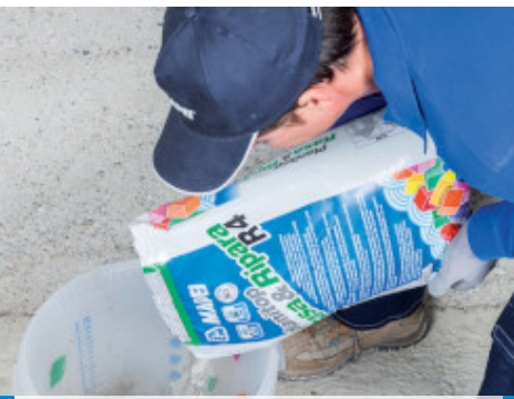
Aggiunta di Planitop Rasa & Ripara R4 o Planitop Rasa & Ripara all'acqua d'impasto additivata con Mapetard ES
