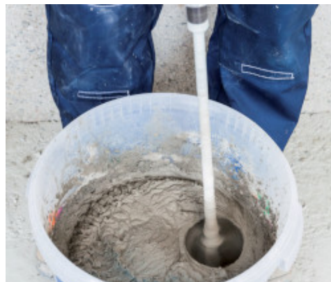
Miscelazione di Planitop Rasa & Ripara R4 o Planitop Rasa & Ripara
